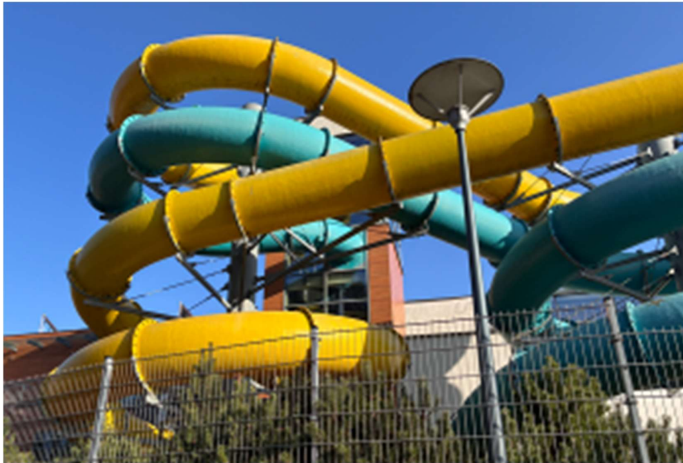
Fot. 44. Widok rur zjeżdżalni
