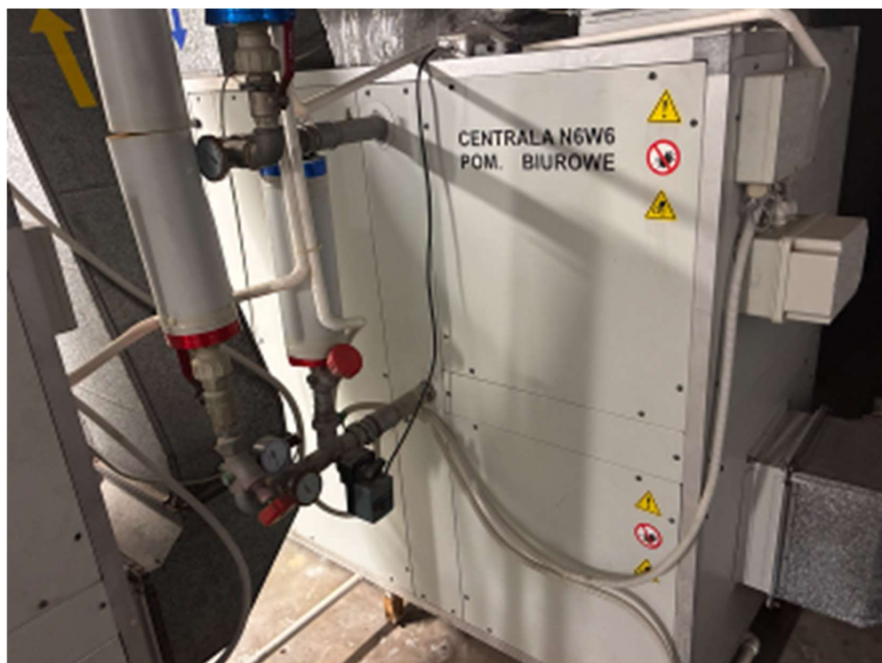
Fot. 55. Centrala wentylacyjna dla pomieszczeń biurowych na poziomie – 1
