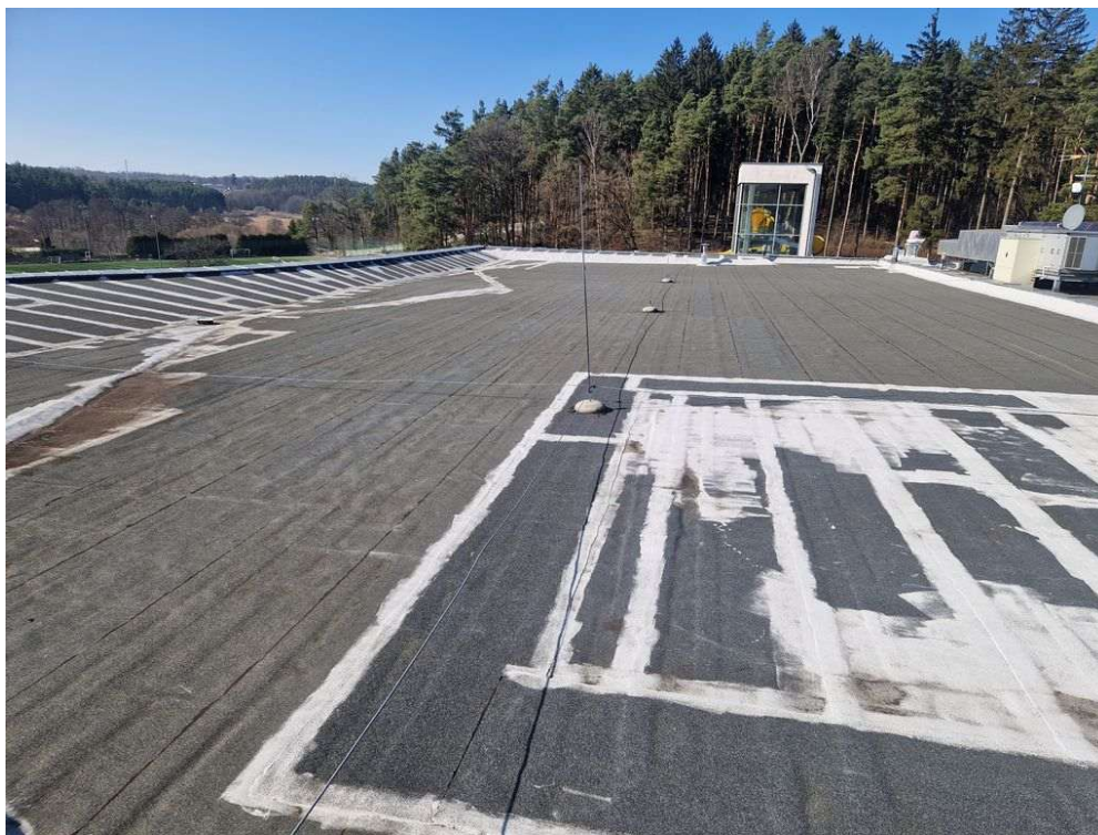
Fot. 89. Widok siatki zwodów poziomych
