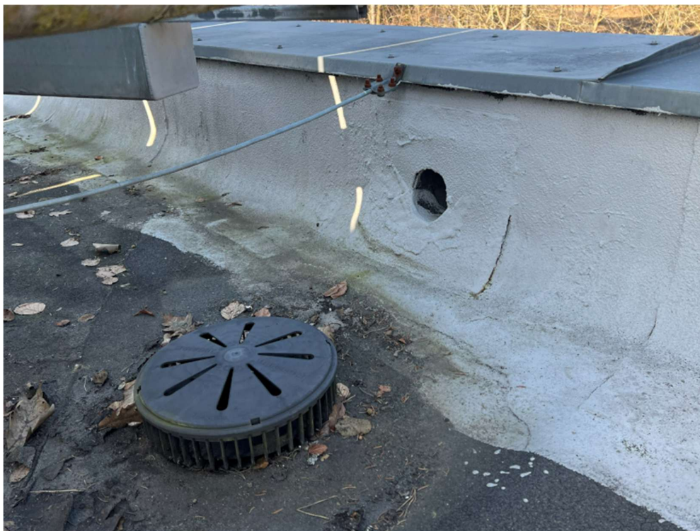
Fot. 22. Widok wpustu dachowego na dachu oraz przepustu awaryjnego
