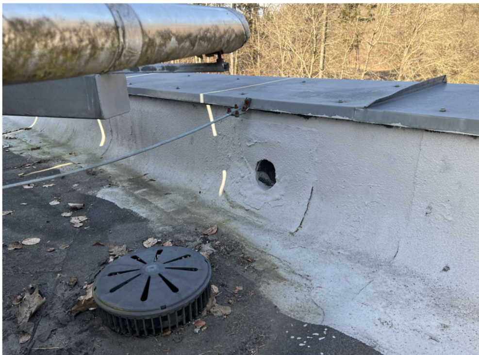
Fot. 72. Widok wpustu podciśnieniowego z przelewem w attyce na dachu
