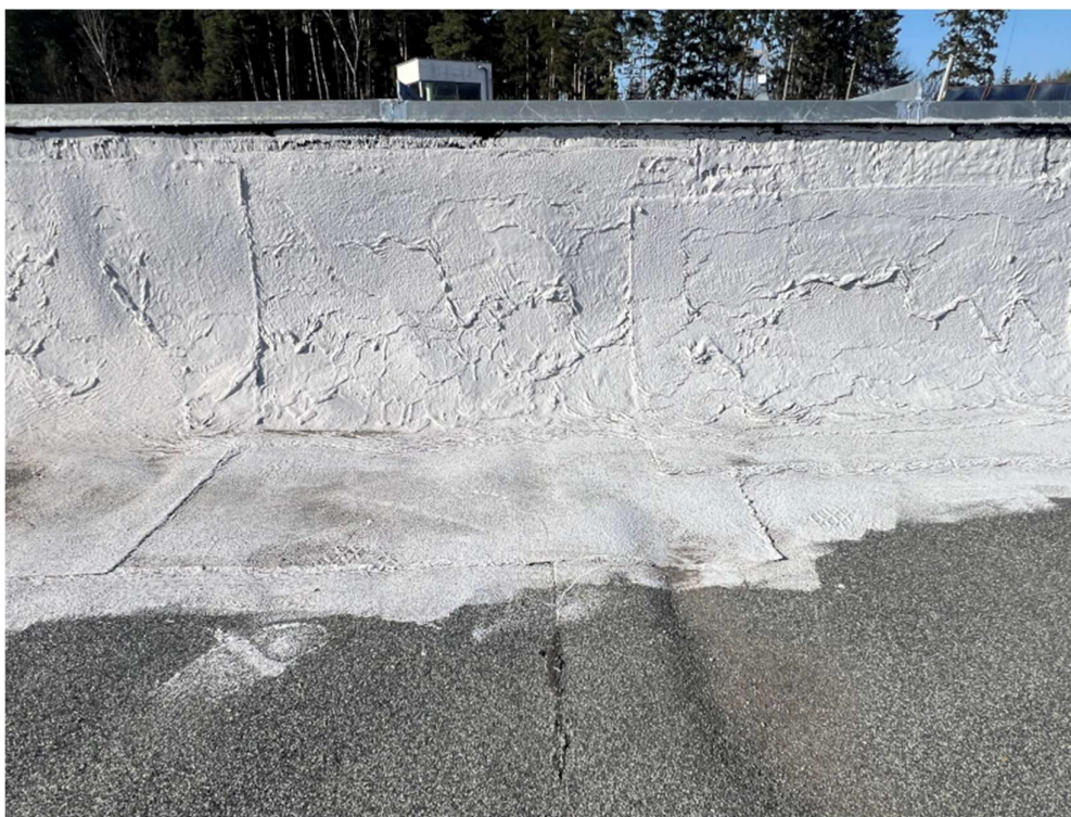
Fot. 29. Widok pokrycia papowego na ścianach attyki po wykonaniu miejscowych napraw
