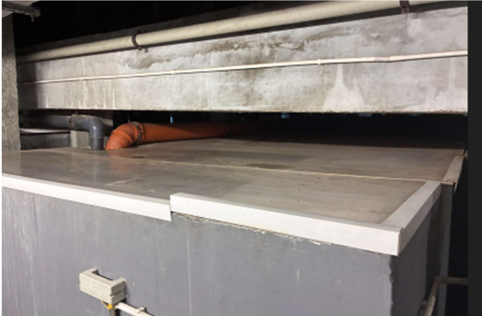
Fot. 48. Zbiornik popłuczyn przykryty klapą niehermetyczną
