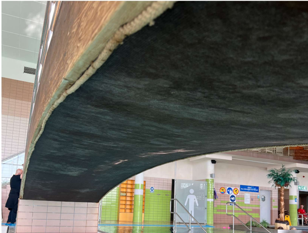
Fot. 21. Widok zastłoniętych elementów konstrukcji mostka nad basenem
