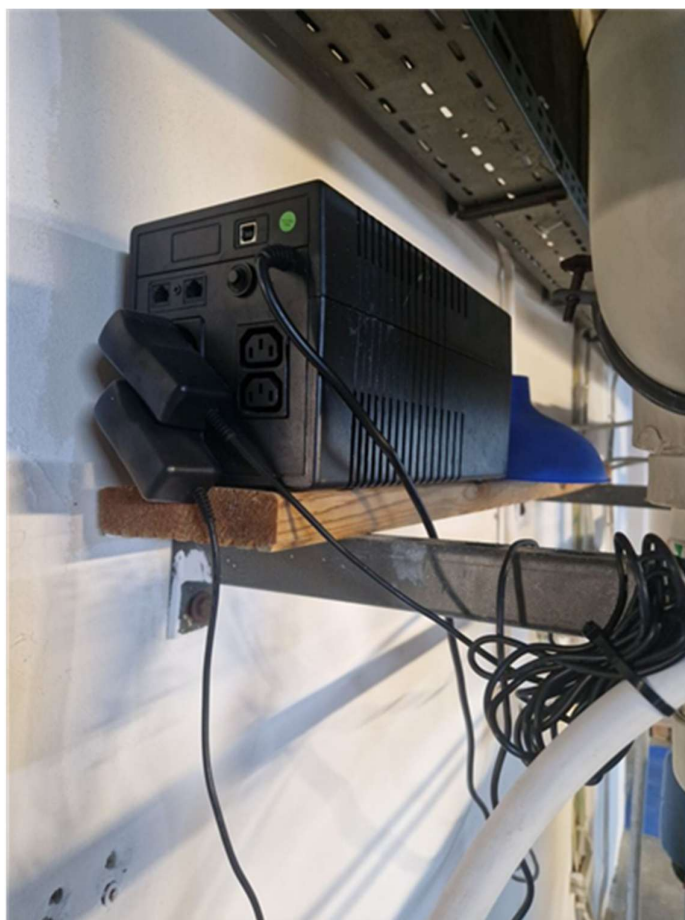
Fot. 85. Zasilacz UPS bez wymaganej osłony
