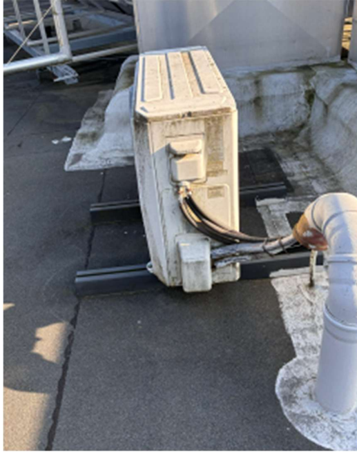
Fot. 60. Agregat chłodniczy jednostki wewnętrznej klimatyzacji
