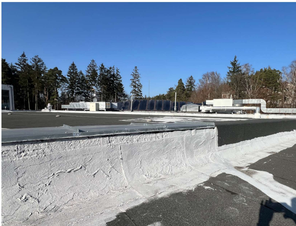
Fot. 28. Widok pokrycia papowego na ścianach attyki po wykonaniu miejscowych napraw
