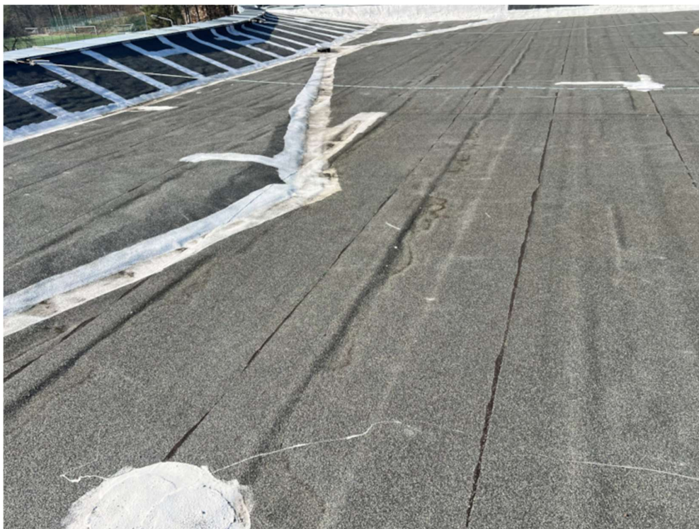
Fot. 26. Widok wierzchniej warstwy papy po miejscowych naprawach
