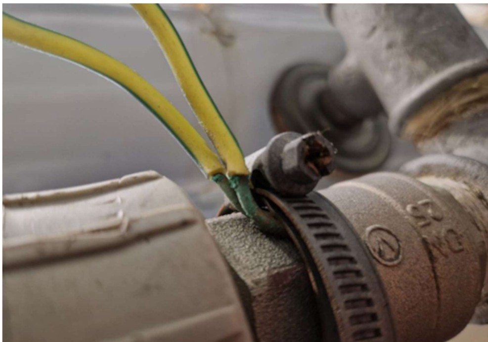
Fot. 82. Prowizoryczne połączenie wyrównawcze do instalacji wodnej
