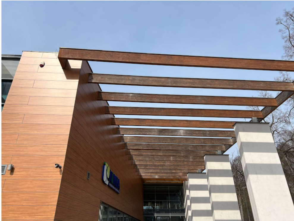
Fot. 34. Widok zadaszzenia przy wejściu głównym do budynku basenu
