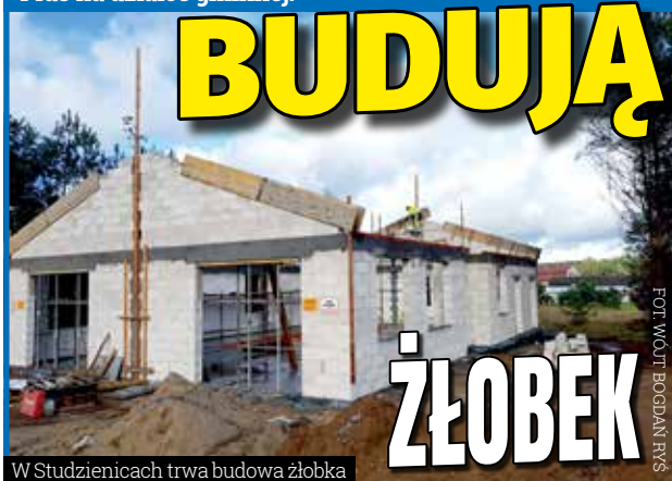
W Studzienicach trwa budowa żłobka
