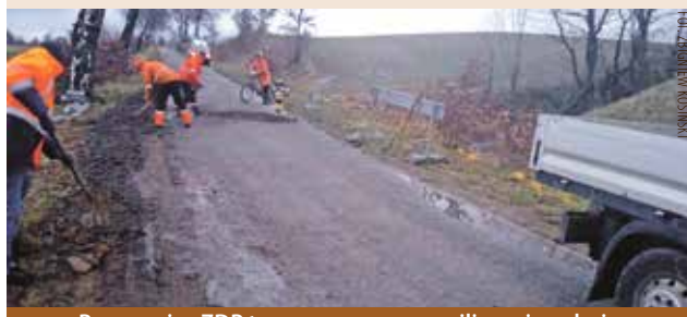
Pracownicy ZDP tymczasowo naprawili nawierzchnię
