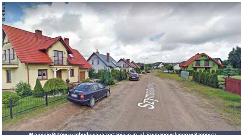
W gminie Bytów przebudowana zostanie m.in. ul. Szymanowskiego w Rzepnicy
