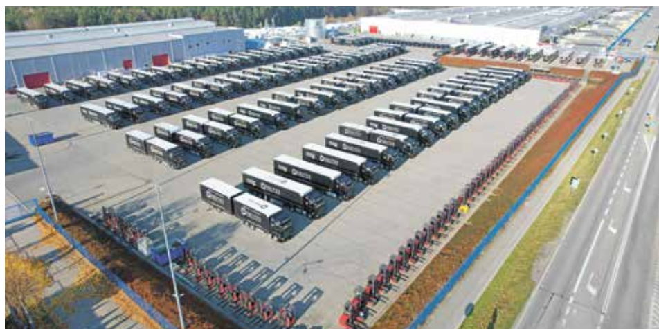
Drutex w 17-tysięcznym Bytowie zatrudnia obecnie 3850 pracowników
