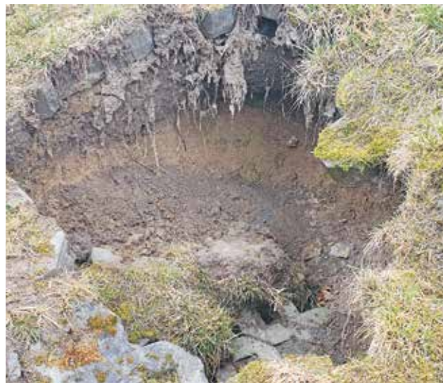
Doskwierający mieszkańcom problem to woda, tzw. deszczówka, zalewająca ich z działek położonych wyżej. W wielu miejscach pojawiają się przez to sporej wielkości wyrwy
