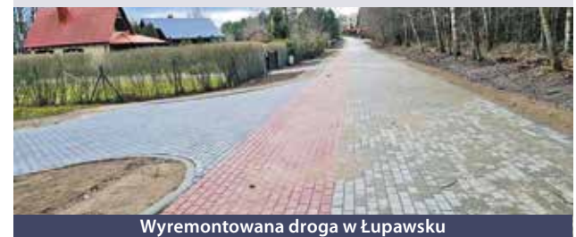
Wyremontowana droga w Łupawsku
