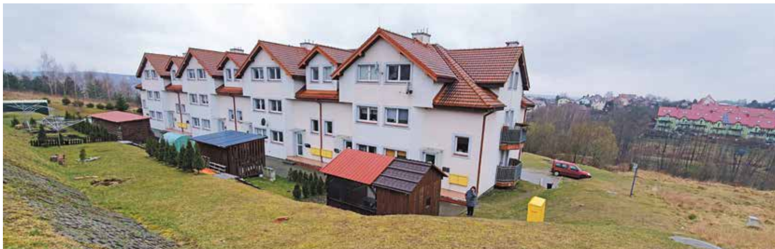
Budynek wielorodzinny, zbudowany przez firmę Cyferka, jak sygnalizowali mieszkańcy, nie ma dogodnych dla kominiarzy dojść do przewodów kominowych
