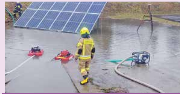
Tak to wyglądało pod koniec zimy, po opadach deszczu
