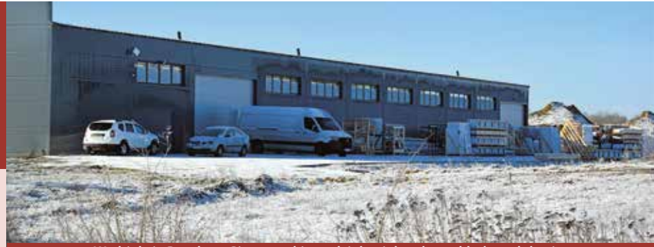
W obiekcie Bogdana Gierszewskiego działa nielegalny zakład produkcyjny
