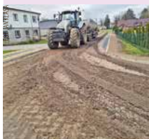
Tak nowy asfalt na osiedlu w Karwnie wygląda po kilku przejazdach maszyn, należących do miejscowego przedsiębiorcy – rolnika
