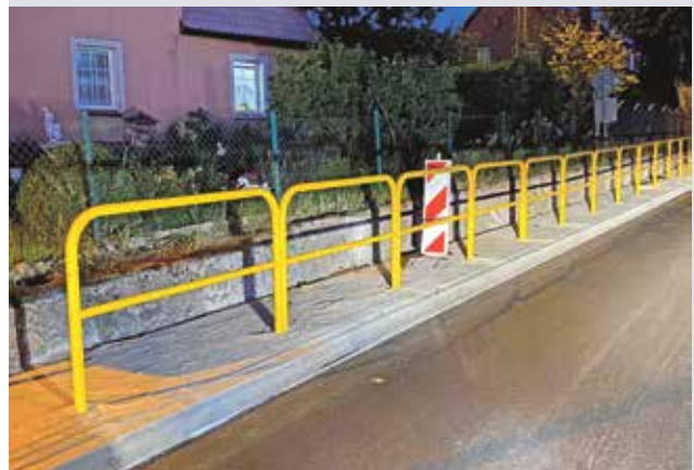
Po modernizacji chodnik w Rekowie został zwężony za pomocą żółtych barier
