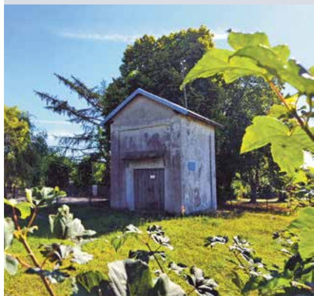
Po budowie nowej sieci wodociągowej zlikwidowana zostanie hydrofornia w Kleszczyńcu, które docelowo służyć ma na cele rekreacyjne dla mieszkańców
