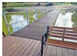
Dzięki budowie pomostu w Nożynie przywrócone do życia ma być kąpielisko
