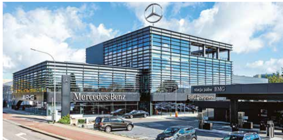
Drutex instalował fasady również w salonach samochodowych, m.in. w Mercedes-Benz BMG Goworowski w Gdyni
