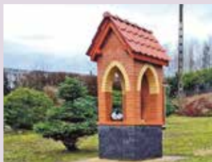
W Kotuszewie za ponad 10 000 zł zbudowano kapliczkę
