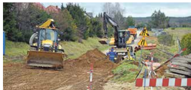
Nowe drogi na Osiedlu Kompozytorów będą droższe w wykonaniu o około pół miliona złotych
