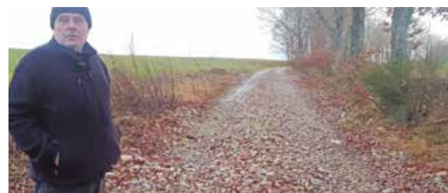
Tak wygląda droga po remoncie wykonanym przez Bielińskich
