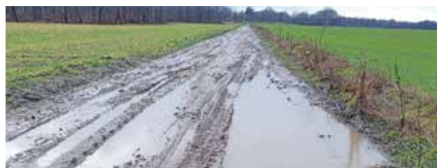
Tak wygląda gminna droga do Nowego Karwna, po remoncie wykonanym przez samorząd
