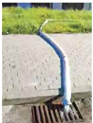
Na ulicy Leśnej wodę z hydrantu przelewano do kanalizacji deszczowej
