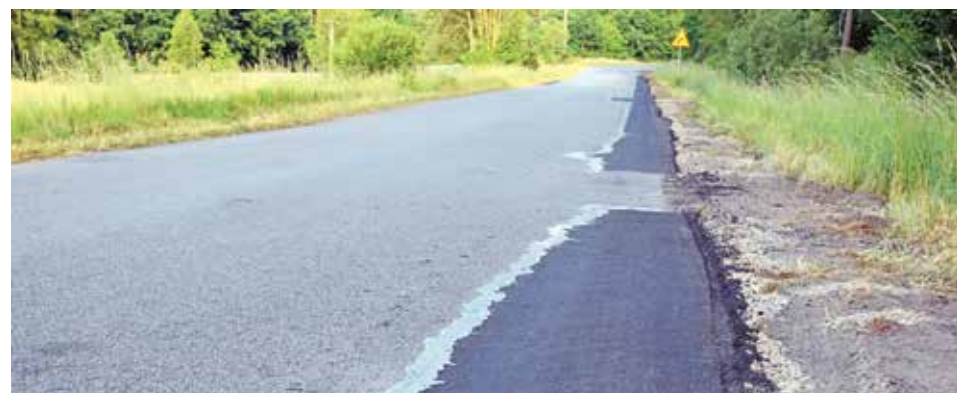
Na oddanej do użytku 3 lata temu po drodze powiatowej w kierunku Grzmiącej pojawiły się już pierwsze łaty, wykonane w ramach gwarancji
