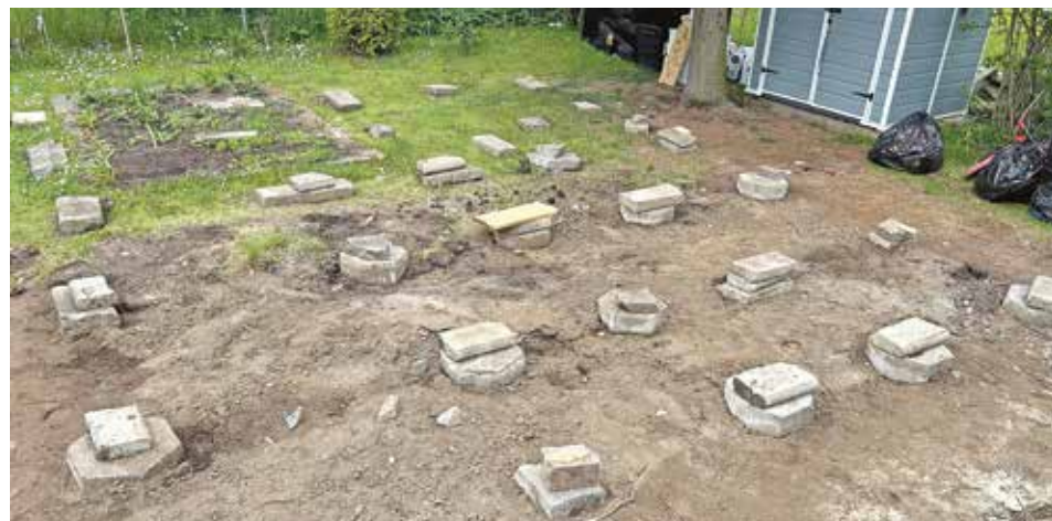
Na takich fundamentach miał być zbudowany domek w Juszkowie pod Gdańskiem
