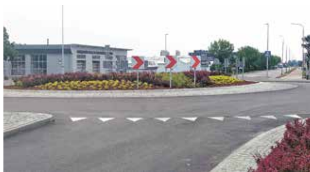
Rondo na ulicy Łęborskiej jest już przejezdne
