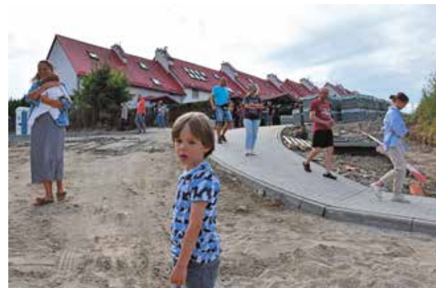
Według mieszkańców ten stromy podjazd na rogu ulicy Fiołkowej będzie bardzo niebezpieczny
