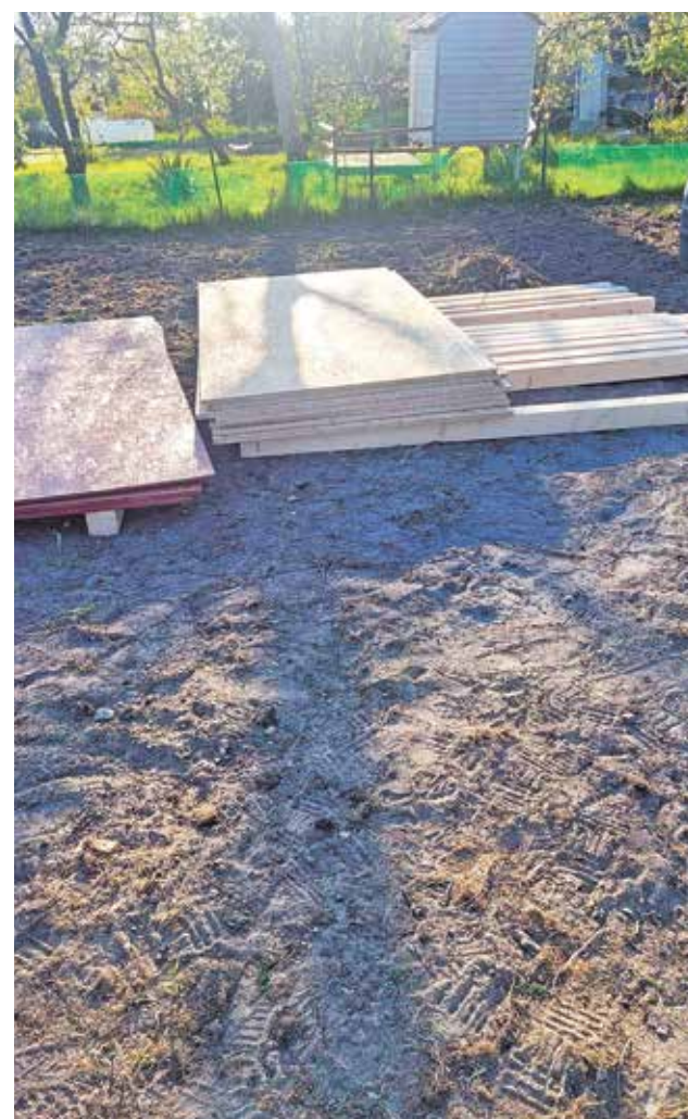
Patrycja Fos doczekała się jedynie rozpoczęcia budowy podłogi
