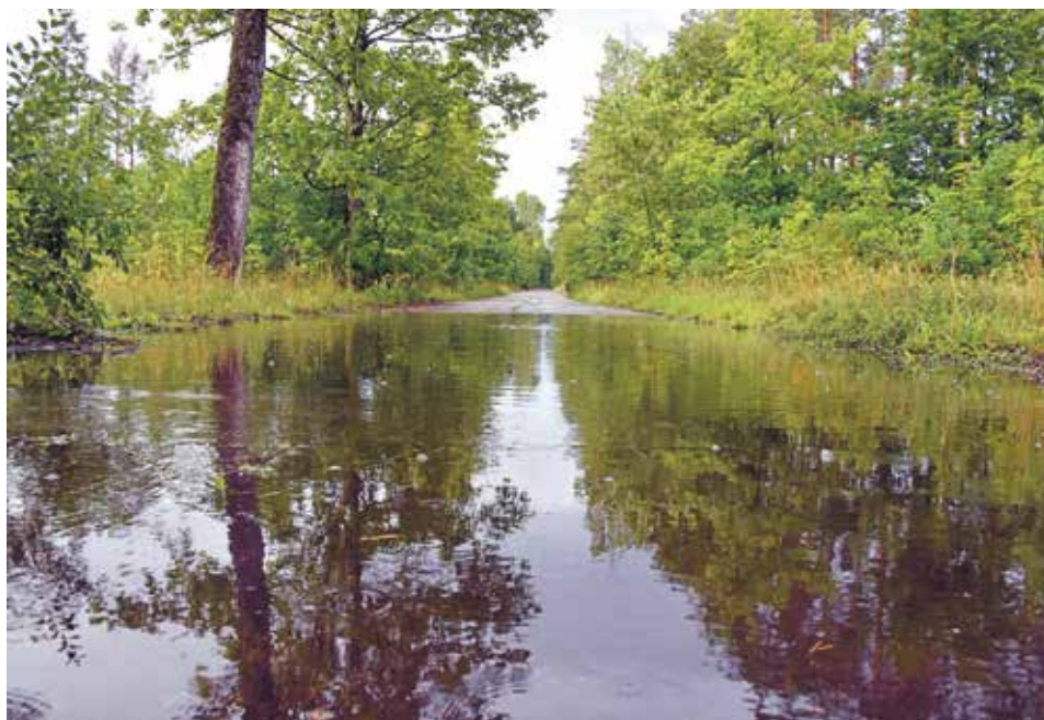
Gmina wspólnie ze spółką Dal-Sol zamierza przebudować drogę nad jeziorem Mausz w kierunku ośrodka wypoczynkowego
