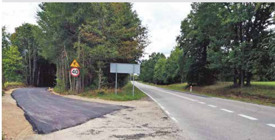
Przebudowa drogi na odcinku Trzebiatkowa - Masłowice kosztowała 438 239 zł
