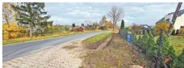
Pierwszy odcinek nowej trasy rowerowej ma być zlokalizowany na drodze powiatowej w kierunku Dąbrówki, na ulicy Gryfa Pomorskiego
