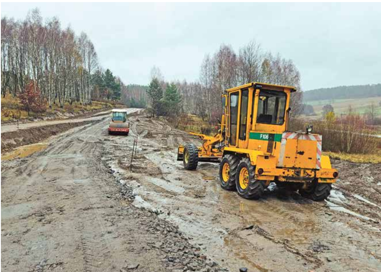
Firma Henryka Reclafa naprawia drogę do działek budowlanych. Koszt to 50 000 zł
