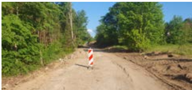
Firma Jereczek za 3,65 mln zł buduje nową drogę z Rekowa do Płotowa
