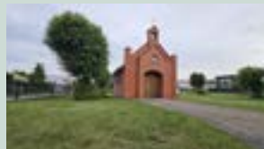
W tym miejscu ma powstać zbiornik na gaz, który nie podoba się radnemu Sokołowskiemu
