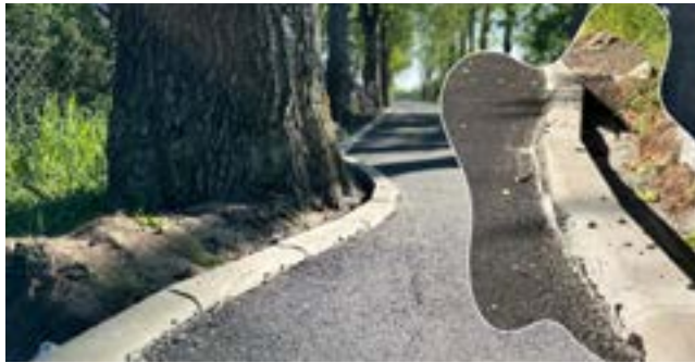
W Dąbiu po modernizacji nawierzchni droga została zwężona w miejscach, w których rosną drzewa
