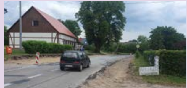
W Nożynie asfalt został już sfrezowany. Będzie nowa nawierzchnia i nowe chodniki
