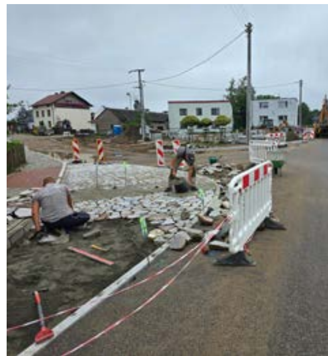
Firma Andrzeja Gliszczyńskiego buduje zupełnie nowe centrum wsi Zapceń FOT. ARCHIWUM
