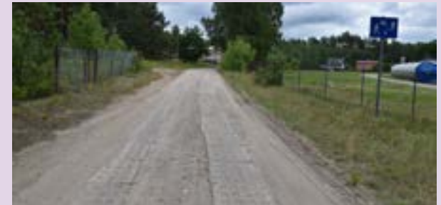
Droga z Soszycy do Strugi zostanie zmodernizowana
