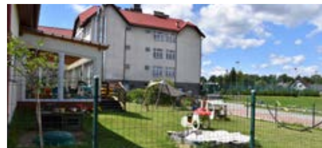
W miejscu altany znajdującej się przy żłobku zostanie zbudowane dodatkowe pomieszczenie dla 7 dzieci
