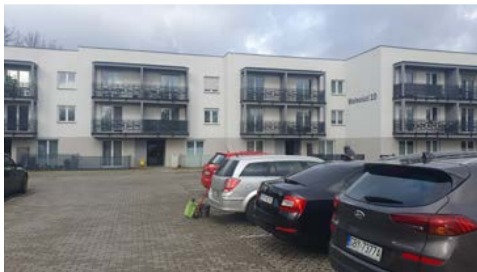
Niektórzy twierdzą, że podczas budowy tego bloku na ul. Wolności zniszczona została jedna z głównych "drenarek"
