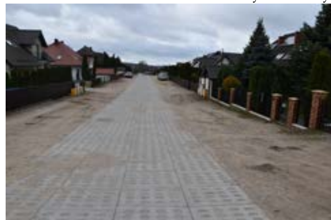
1 132 795,20 zł będzie kosztować przebudowa ulicy Piwoni w Bytowie
