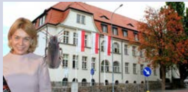
Więźba dachowa na bytowskim ratuszu jest pożerana przez kołatkę upartego
