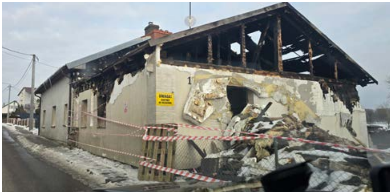
Dom 22-letniej kobiety nadaje się do rozbiórki
