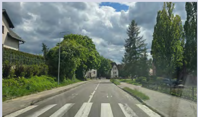
Odcinek ulicy Mierosławskiego o długości 320 m zostanie zmodernizowany. Niebawem ogłoszą przetarg
