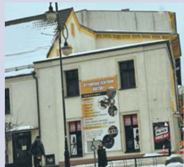
Trwają ostatnie prace przed rozbiórką starego budynku BCK
